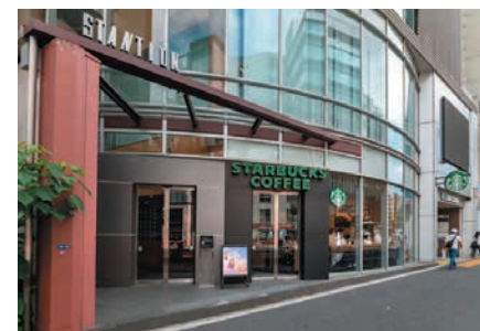
エントランスと1階店舗
