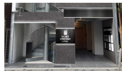
『VORT 日本橋本銀通り（仮称）』上：外観
