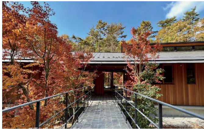
大きな屋根が目を引く外観（2023年10月撮影）
