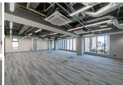
14階オフィスフロア室内 (いずれも2023年11月撮影)
