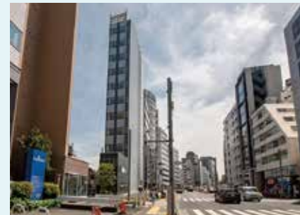
明治通りから全景を望む
