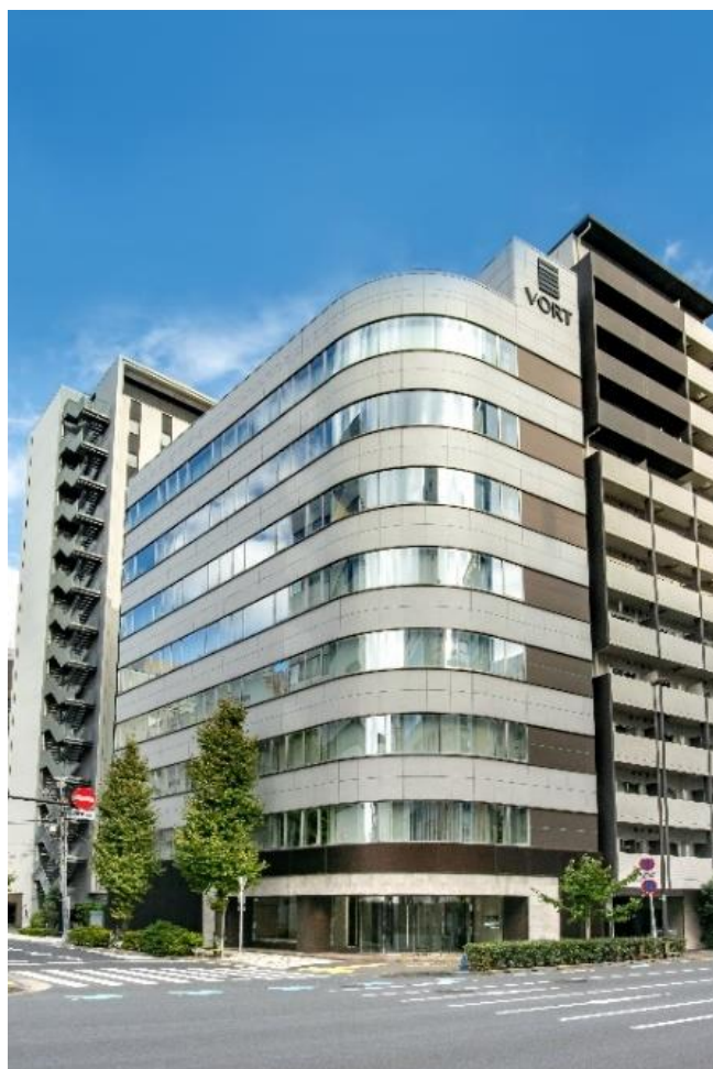
VORT 新橋Ⅲ（外観）※2020年10月撮影
