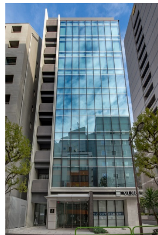
VORT 水道橋Ⅲ 外観 ※2020年4月撮影
