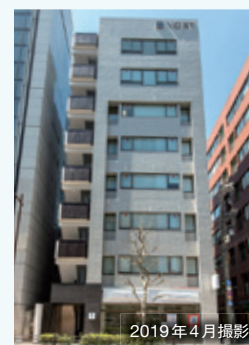
VORT 水道橋 II
