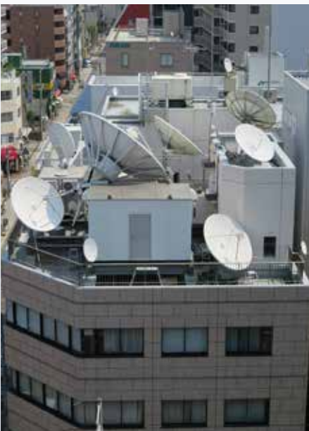
本社屋上に設置された衛星通信用パラボランテナ群
