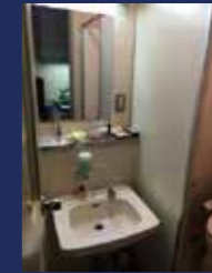
WC洗面カウンター 現況写真
