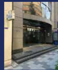
ファサード現況写真
